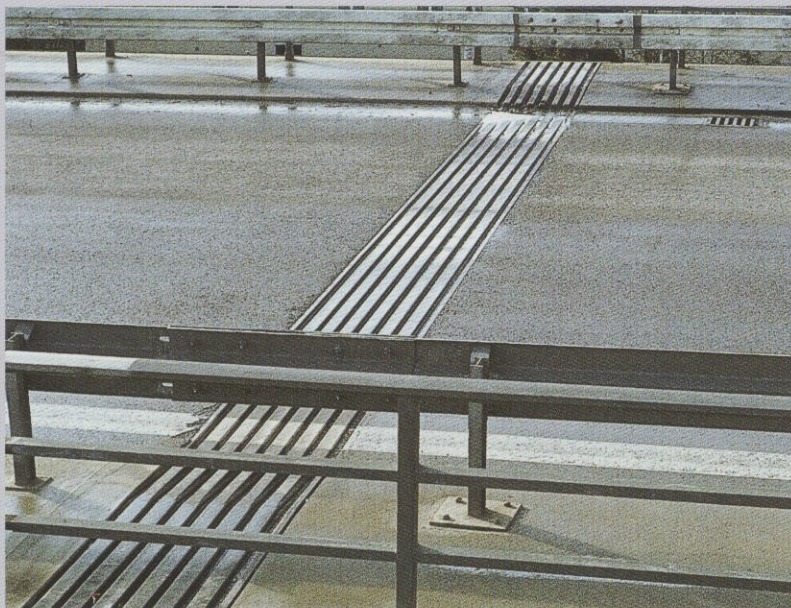
Joint à grillage de poutres type D 560
